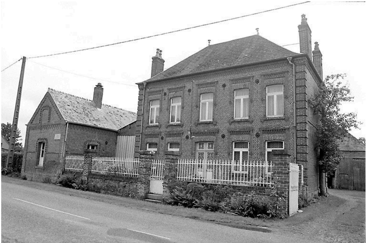
Vue générale : à droite le logis, à gauche la laiterie.
