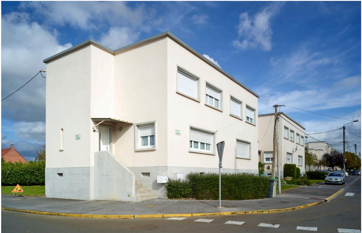
Vue des pavillons situés aux extrémités de l'opération (bloc C), prise depuis la rue.
