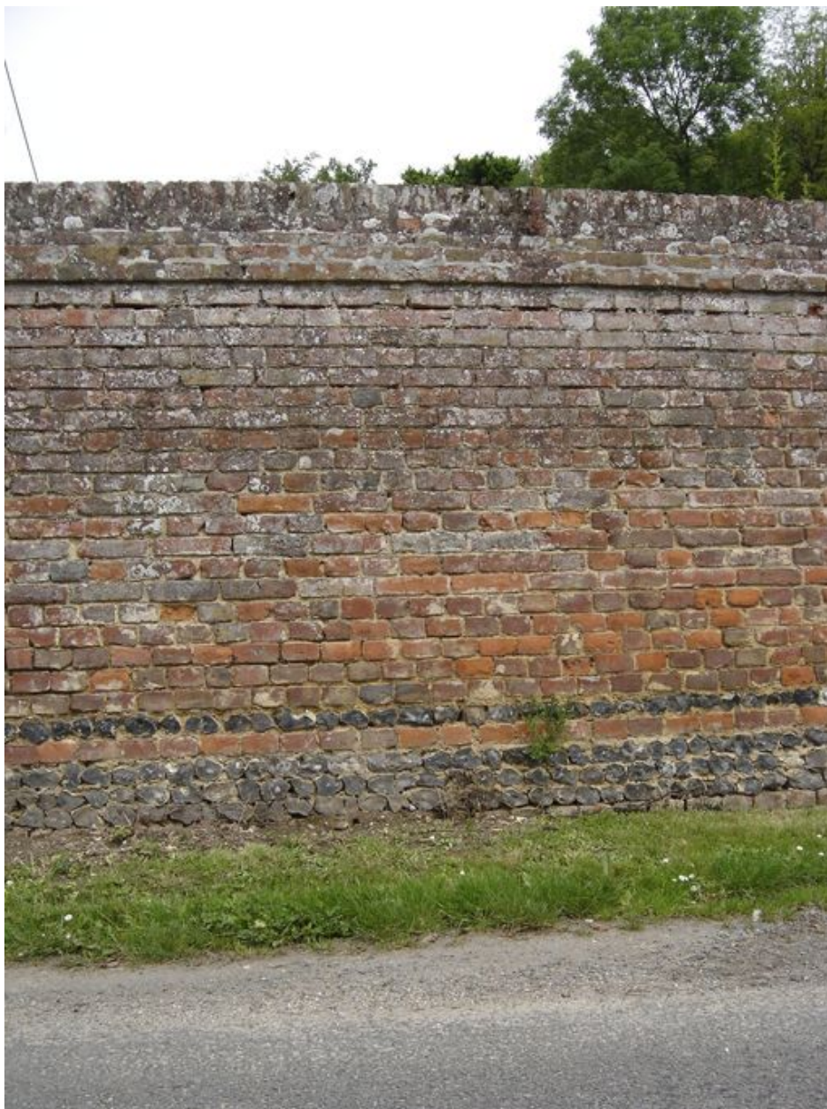
Vue du mur de clôture.
