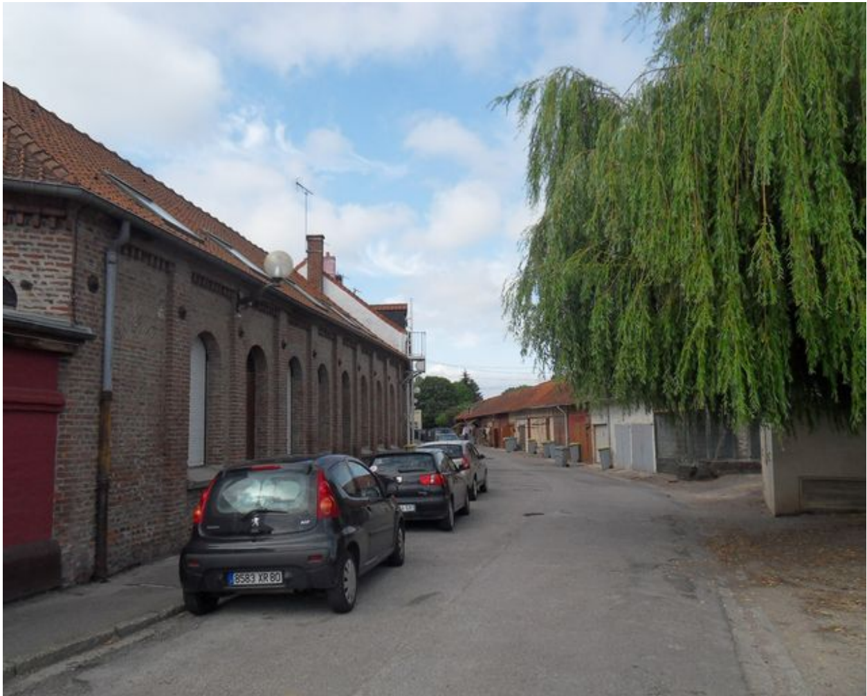
Vue générale. L'ancienne cantine au premier plan.
