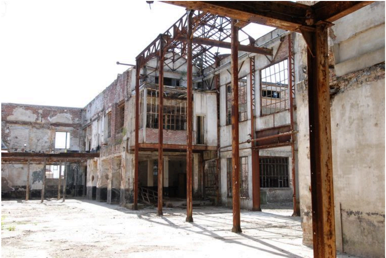
Intérieur de l'atelier de fabrication primitif, dit halle Thirial.
