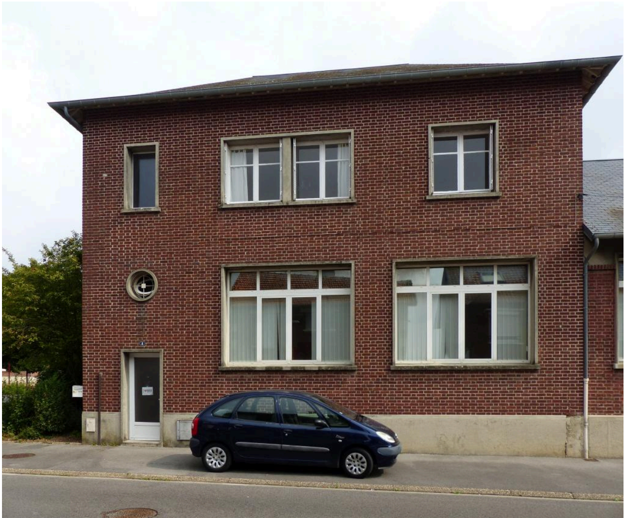
Le pavillon à étage (rue Fernand-Bouyssou).
