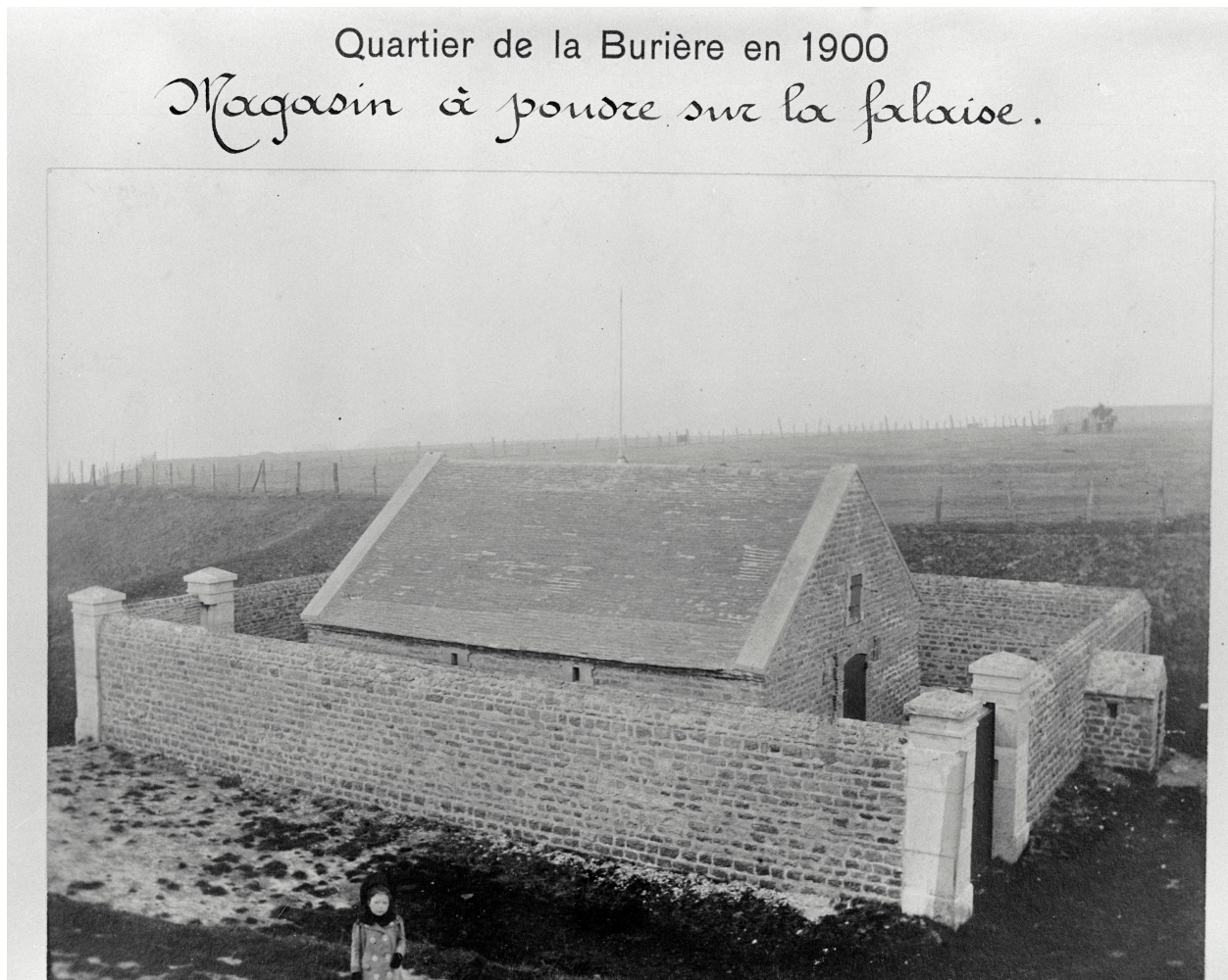
Vue d'angle sud-ouest, en 1900. A.C. Boulogne-sur-Mer, clichés 1900.
