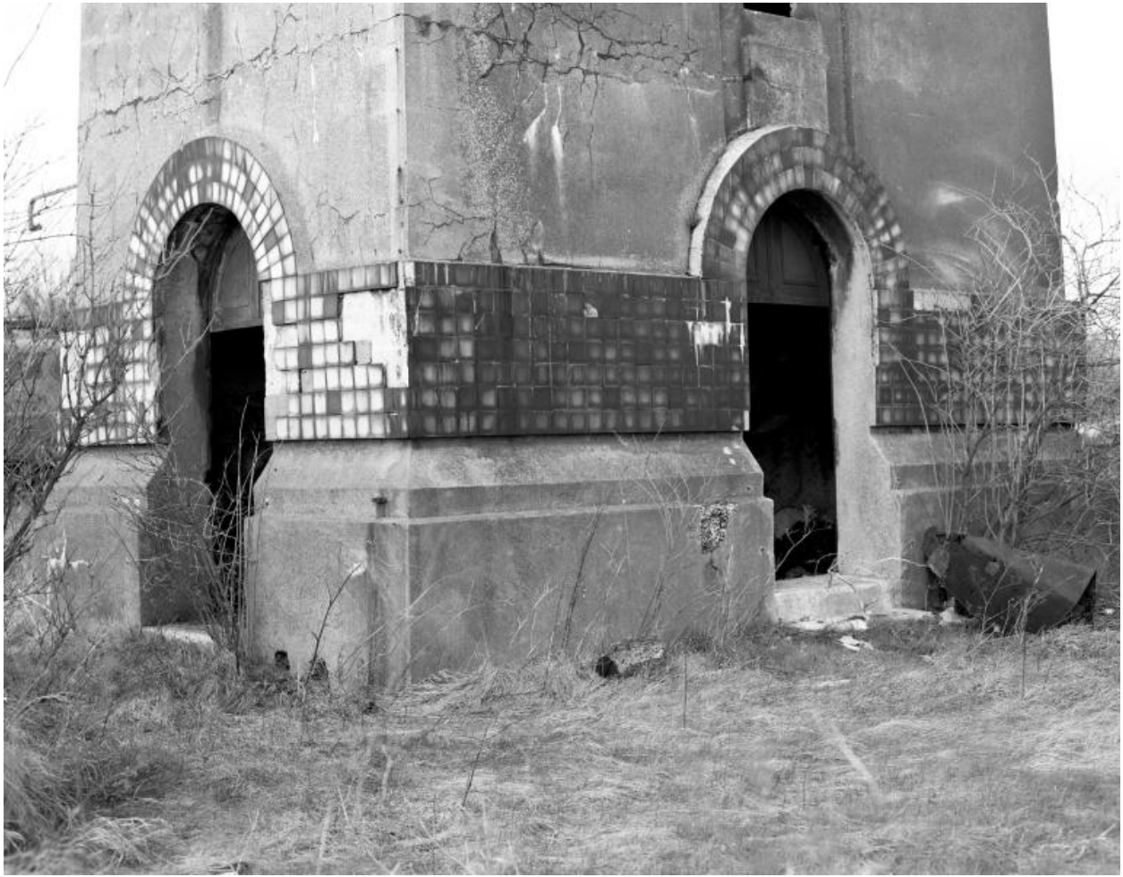
La base de la tour d'aiguillage.
