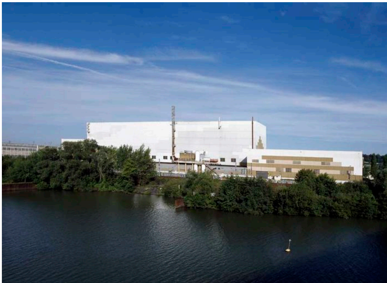
Bâtiment du recuit-continu.
