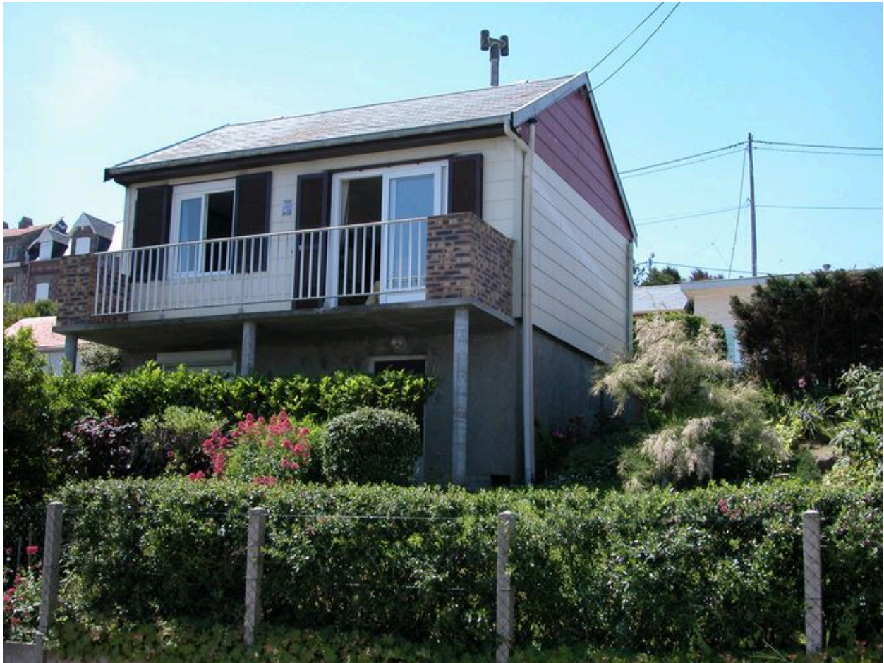
Maison, 35 boulevard Carnot (AC 106).
