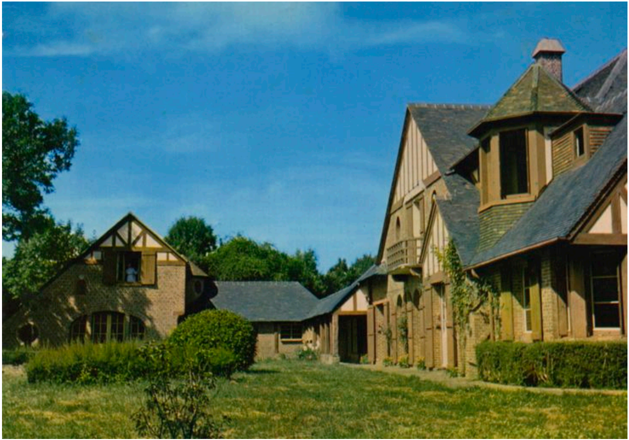
Élévation postérieure, vers 1960 (coll. part.).
