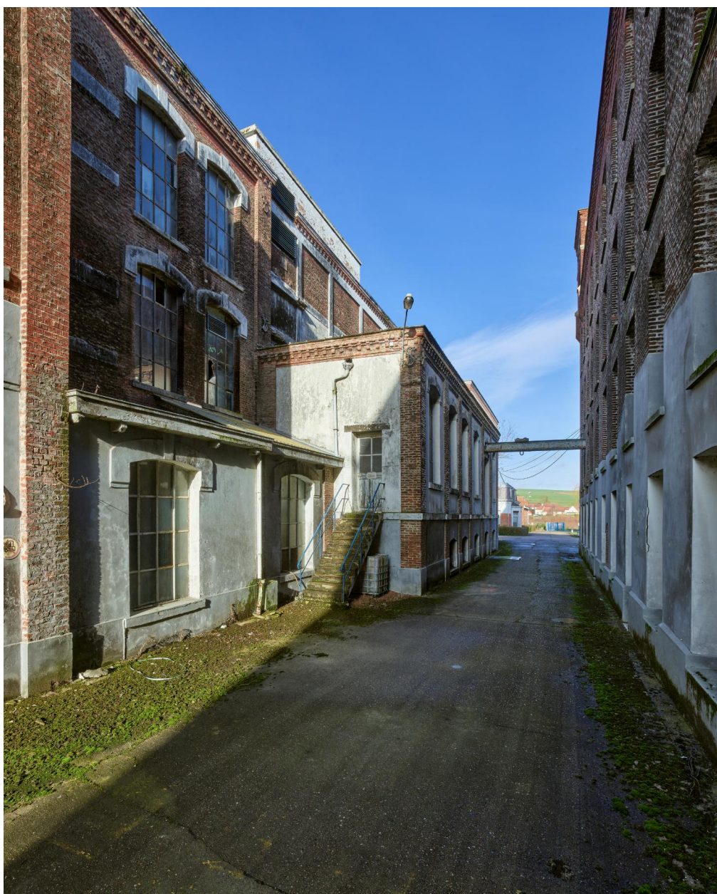
Salle des générateurs électriques, vue depuis le sud.
