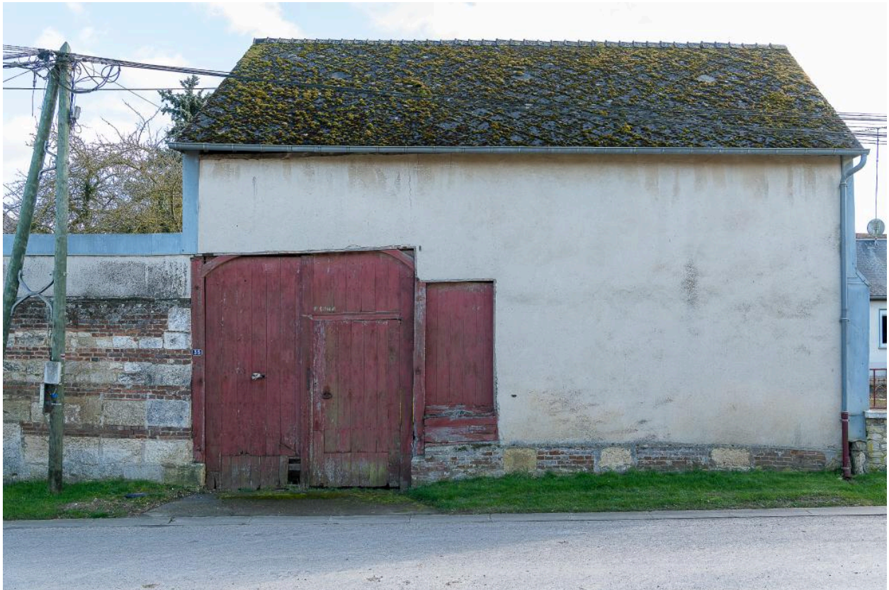
Grange sur rue avec entrée charretière, n°35 Grande Rue, vue depuis le nord.
