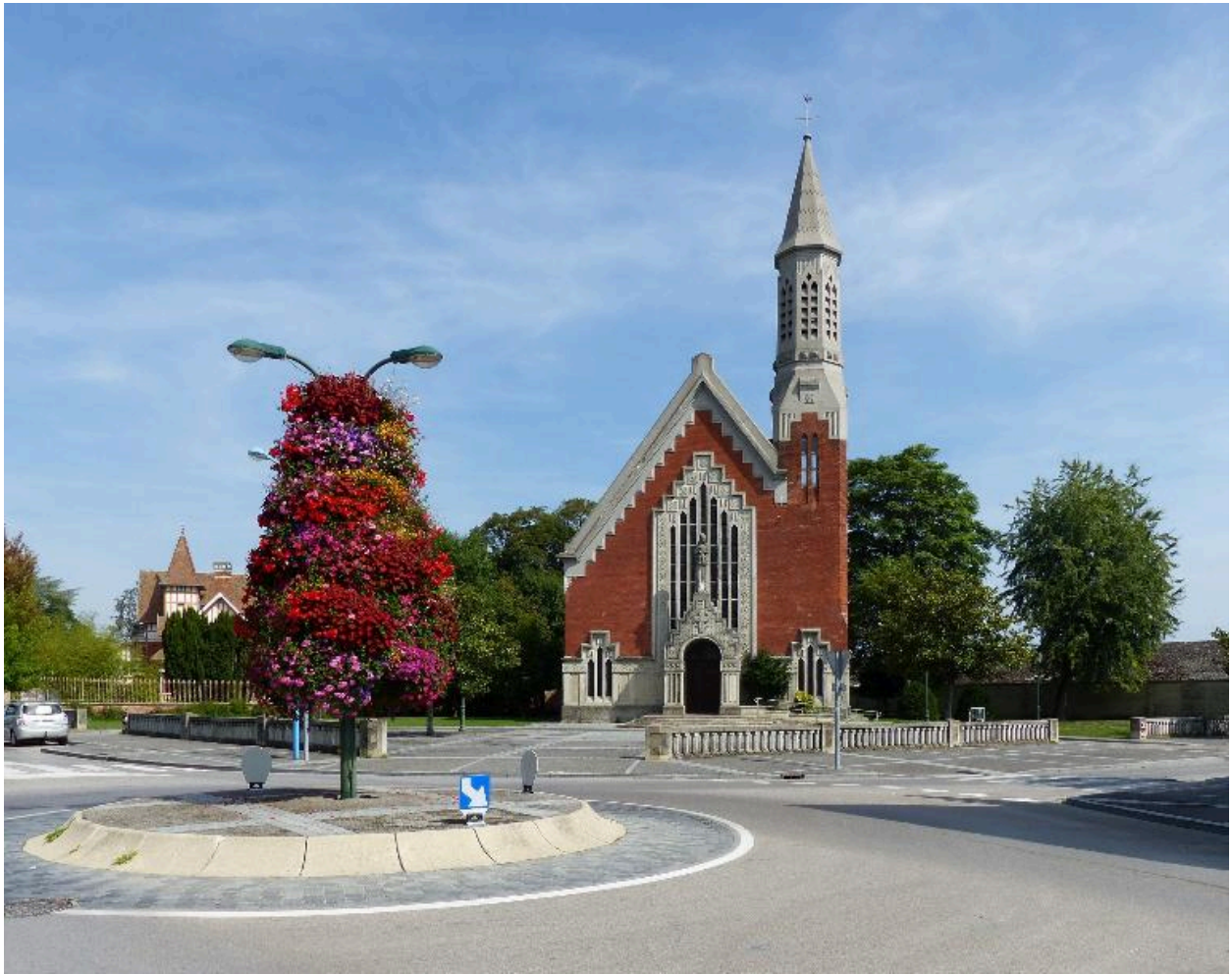
Vue de situation depuis le rond-point.
