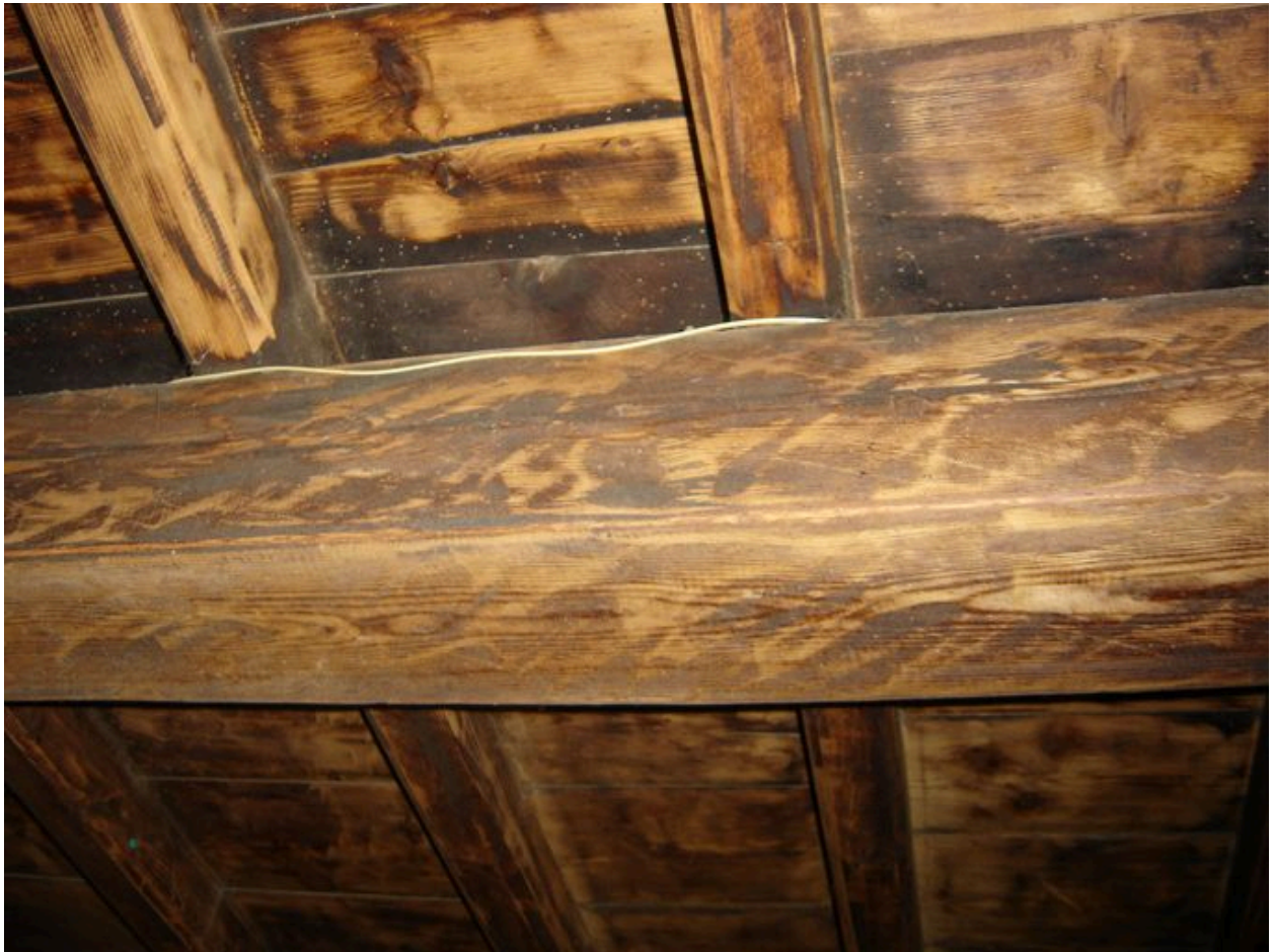
Vue du plafond de la salle d'été.
