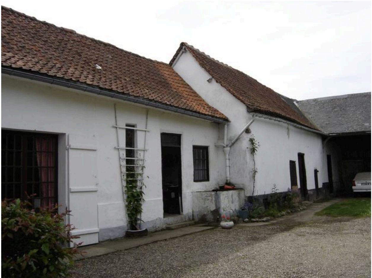
Vue des étables et écurie longeant la partie ouest de la cour.
