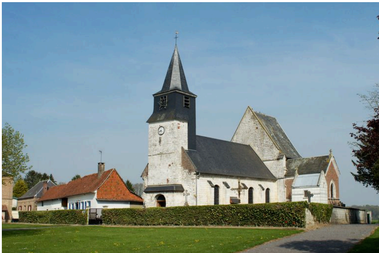
Vue générale depuis le sud-ouest.
