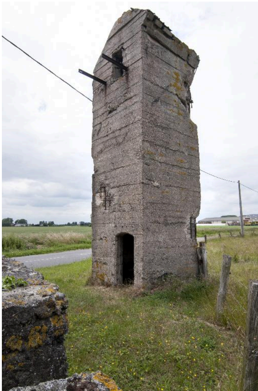
Vue de trois-quarts de l'observatoire, vers l'ouest
