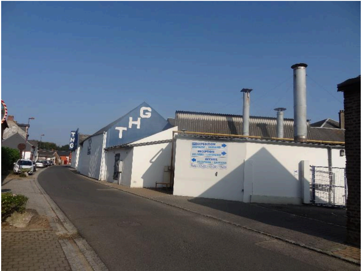
Usine de robinetterie THG, rue Tournière.
