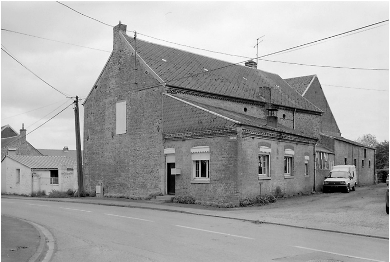
Vue de l'élévation postérieure du logis.
