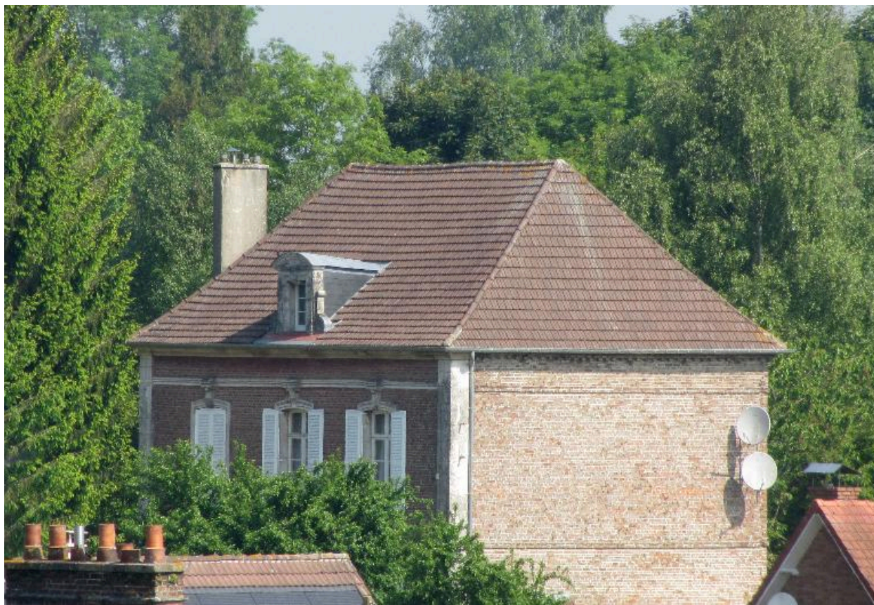
Vue de la maison depuis les hauteurs du village.
