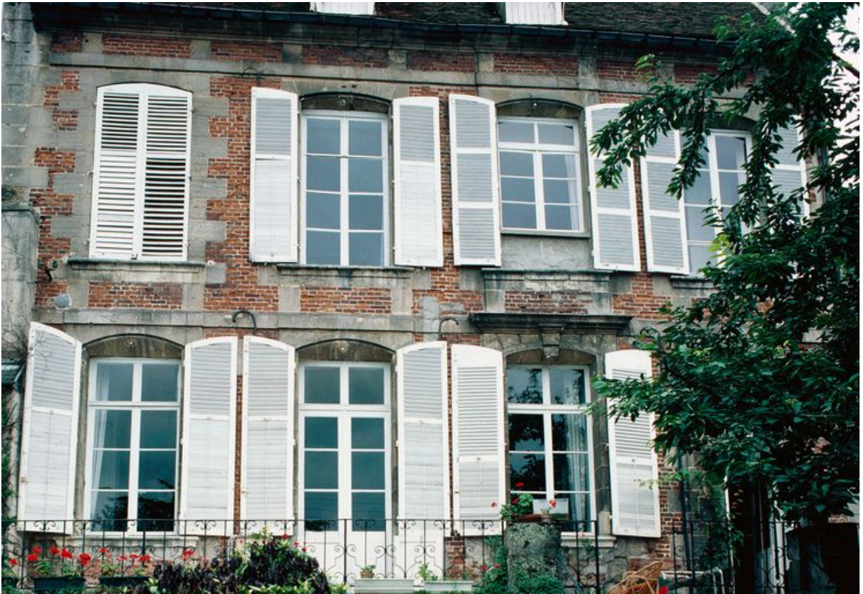
Elévation postérieure, vue partielle.
