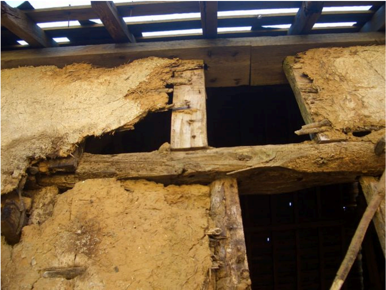
Vue du surcroît.
