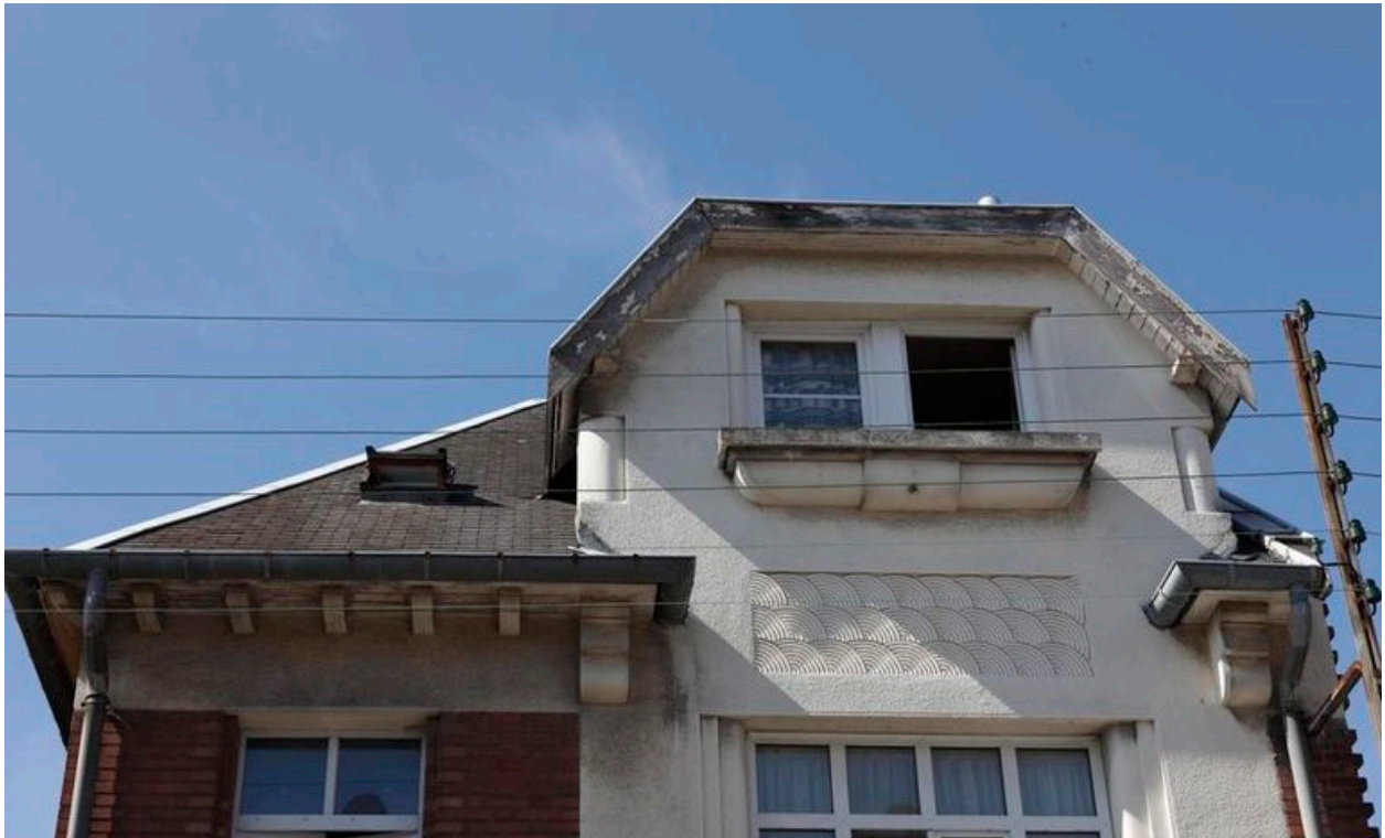
Vue sur la partie haute de la façade.
