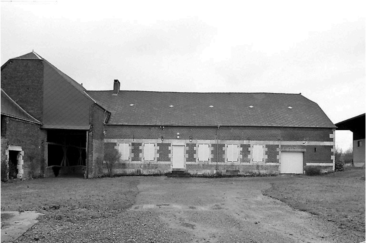
Logis et grange traversante.
