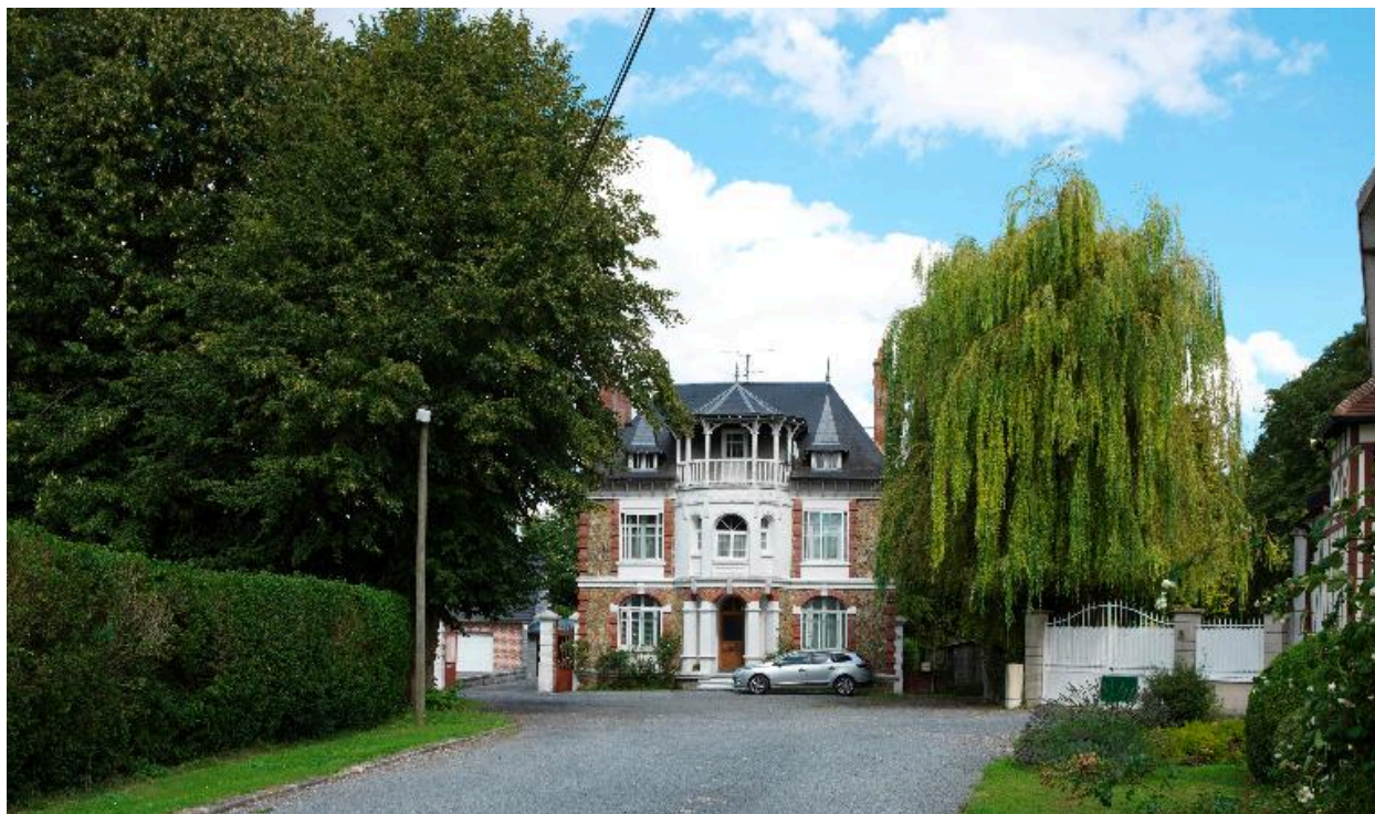
Maison, 35 rue Joliot-Curie.
