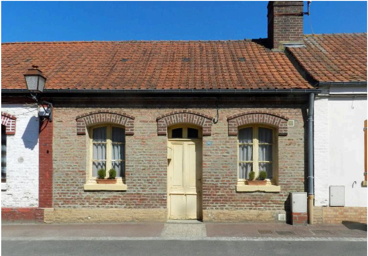
Vue de la façade d'un des logements de la cité.
