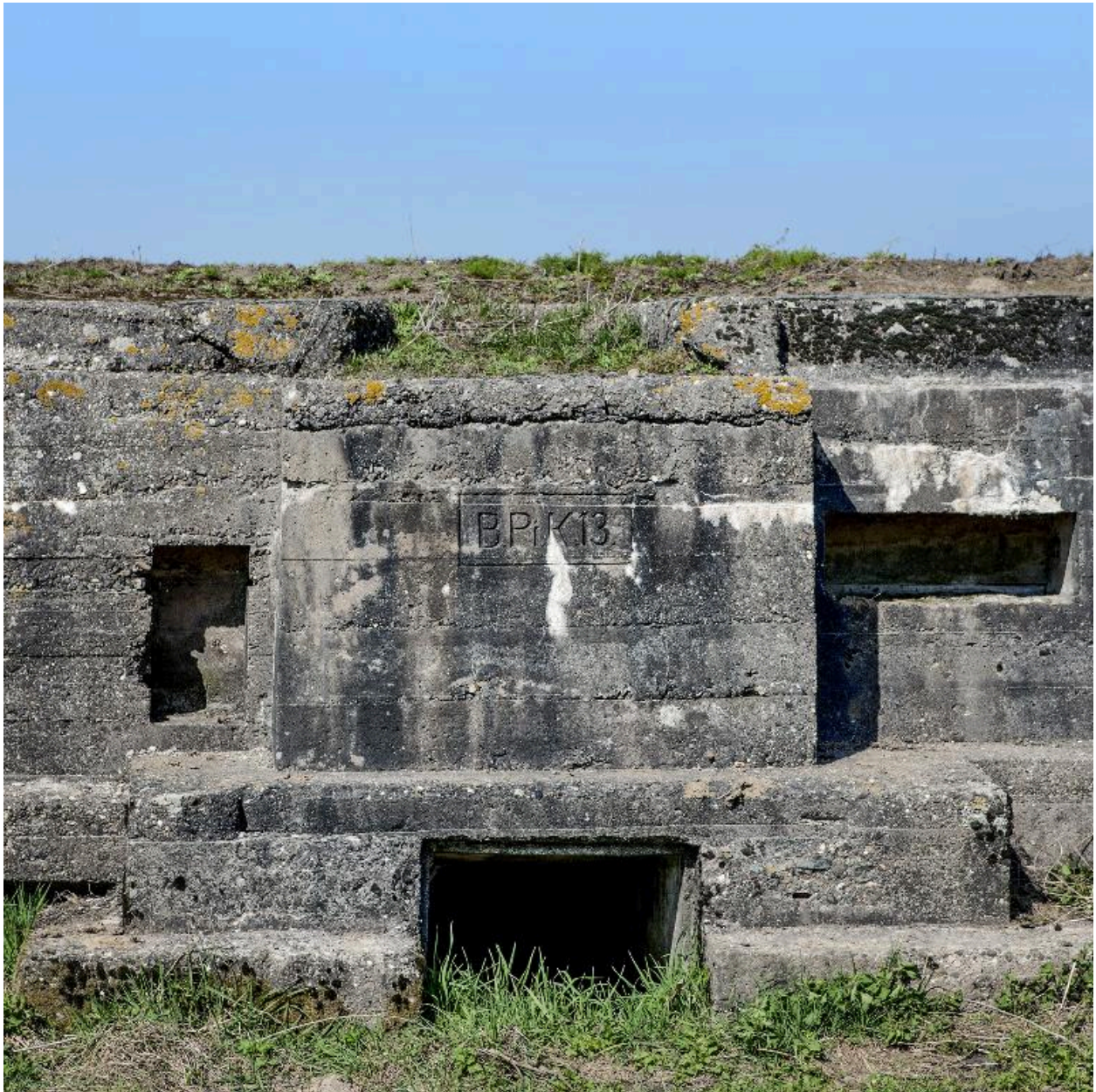
Elévation sud : Banquette de tir encadrée de niches à munition. Au niveau du sol, la resserre à mitrailleuse
