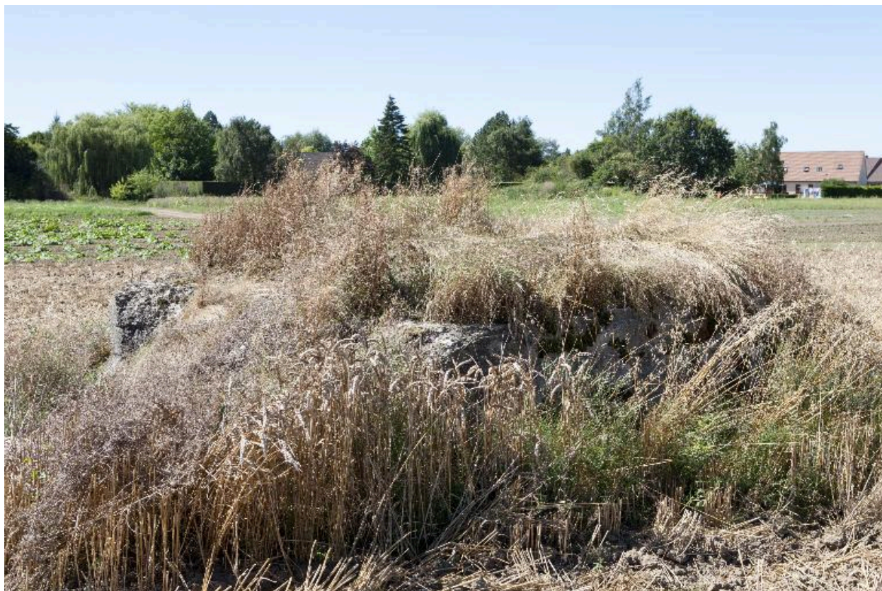
Casemate sud, vers l'ouest
