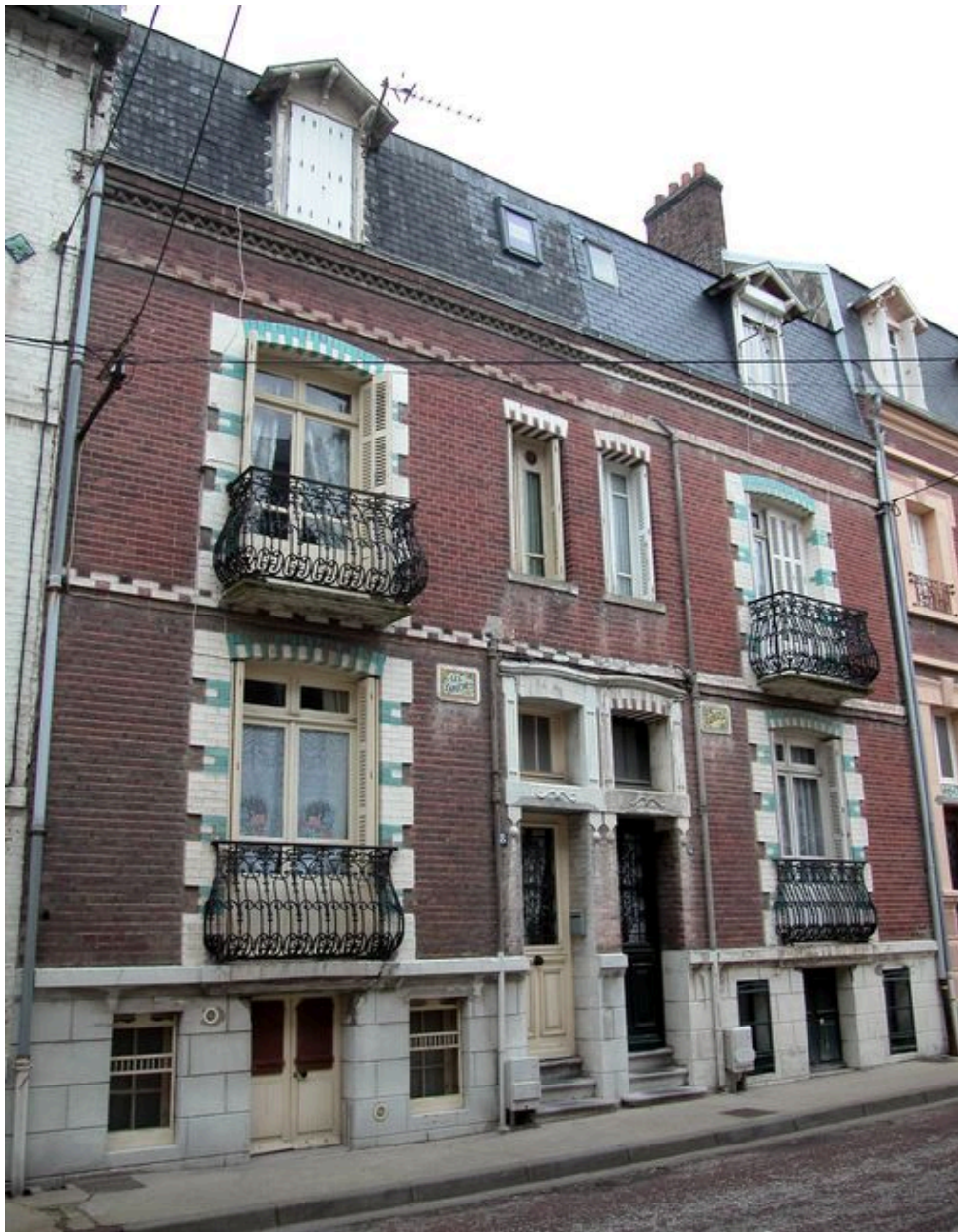
Vue d'ensemble depuis la rue
