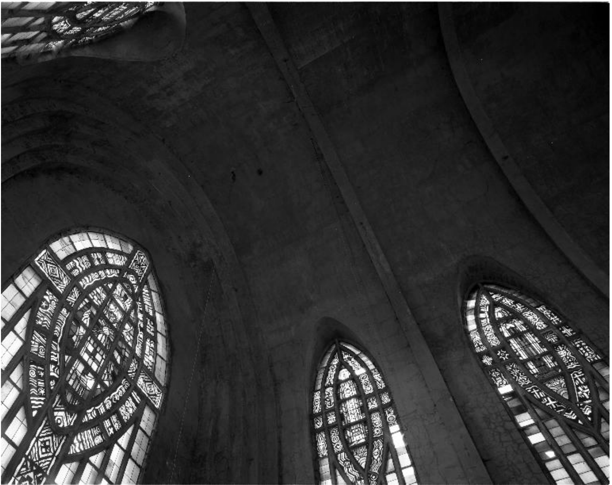
Voûte du choeur, partie Est.
