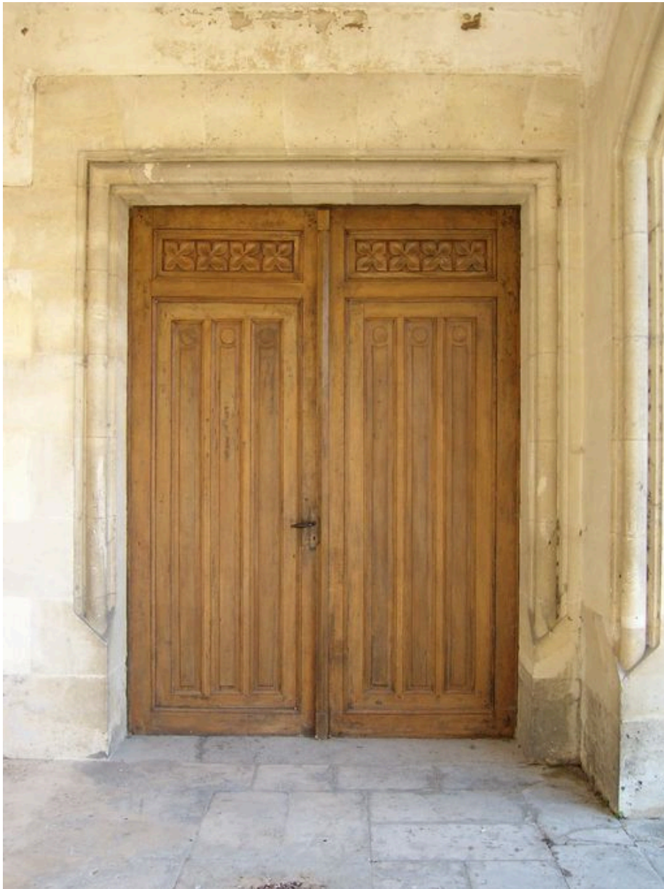
Vue de la porte d'entrée à deux vantaux.
