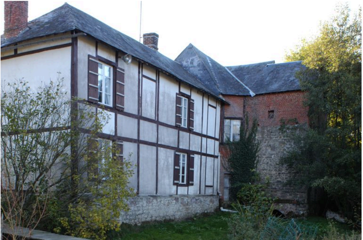
Vue d'ensemble du moulin et de l'habitation, façade nord.
