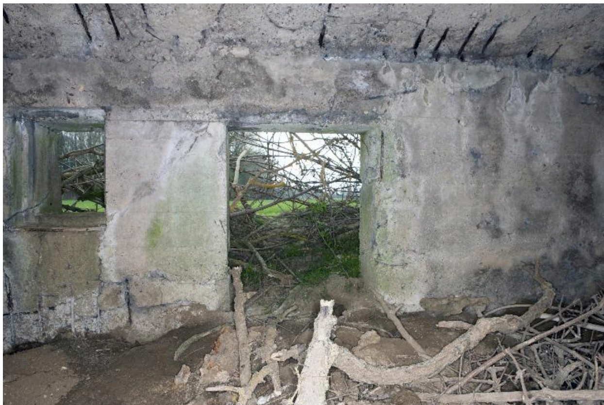
Vue intérieure, salle sud, vers l'est
