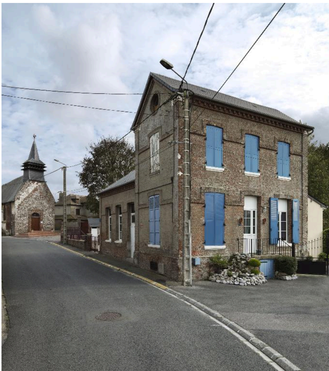
Ancienne école des filles, allée des Ecoliers.
