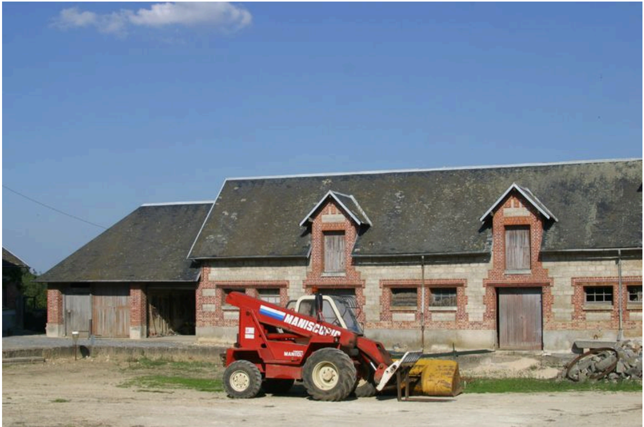
Vue de l'écurie située dans le prolongement du pigeonnier
