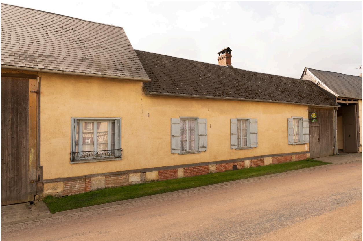
Logis sur rue, n°8 de la Neuve-Rue, vue prise depuis le nord.
