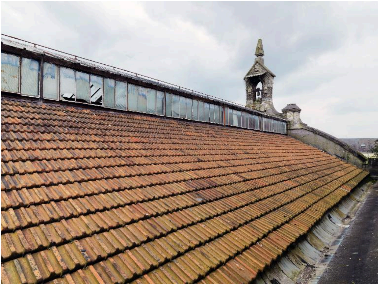
Vue de la toiture et du clocheton de l'atelier principal.
