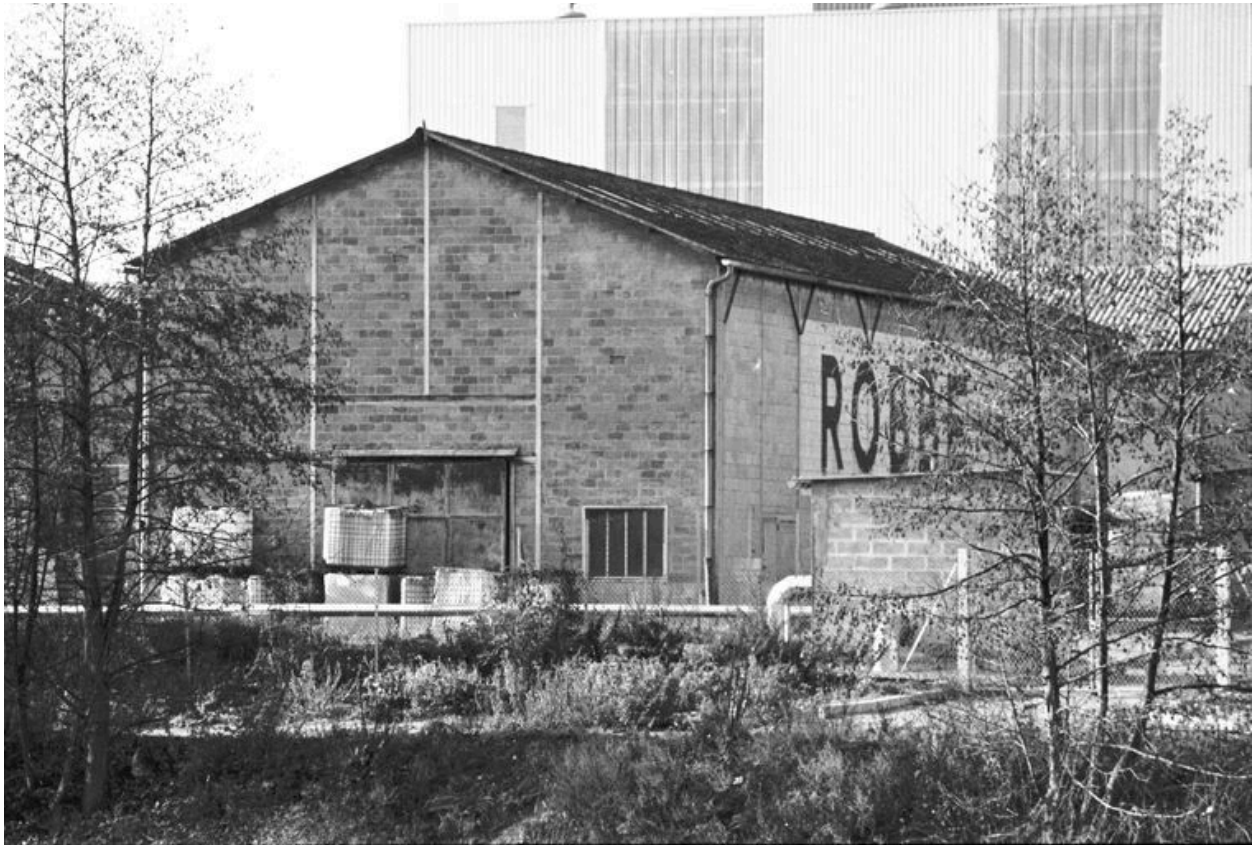
Magasin industriel, flanc est.
