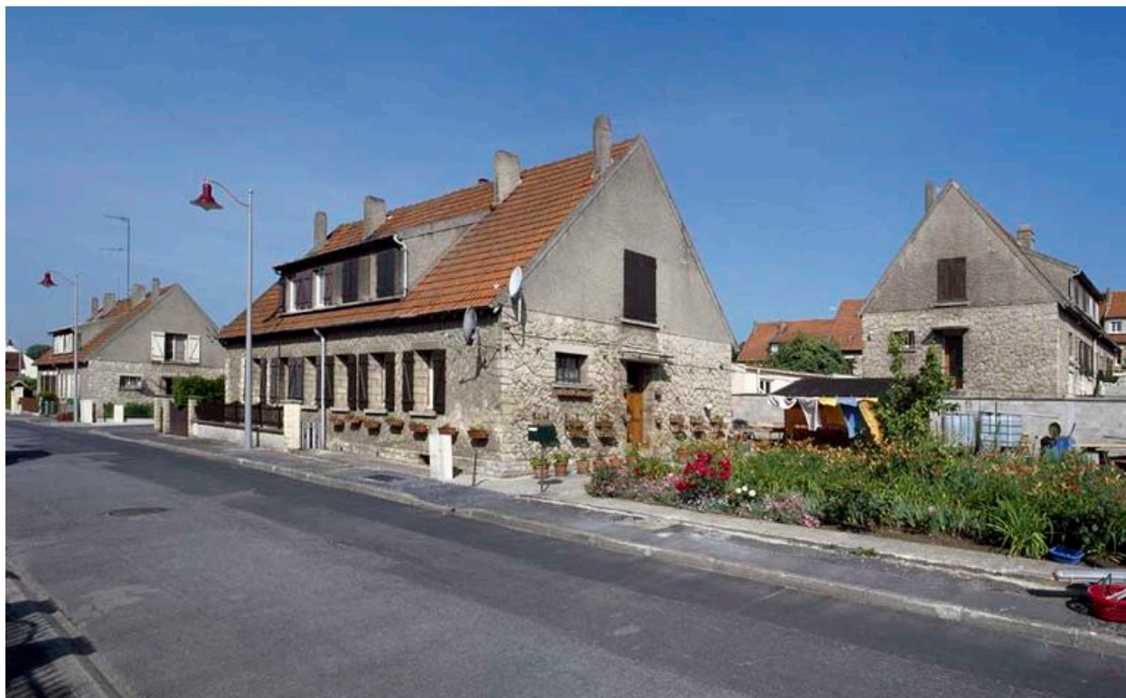
Vue générale de la cité Entreil depuis la rue Aristide-Briand.
