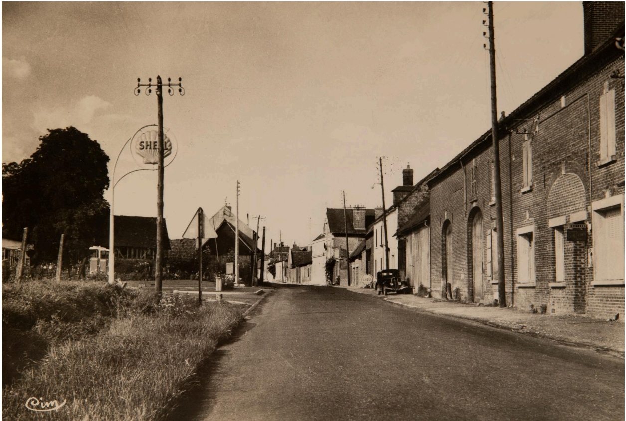
Froissy (Oise). Station-service de la rue de Beauvais, photographie, [années 1970] (coll. part.).
