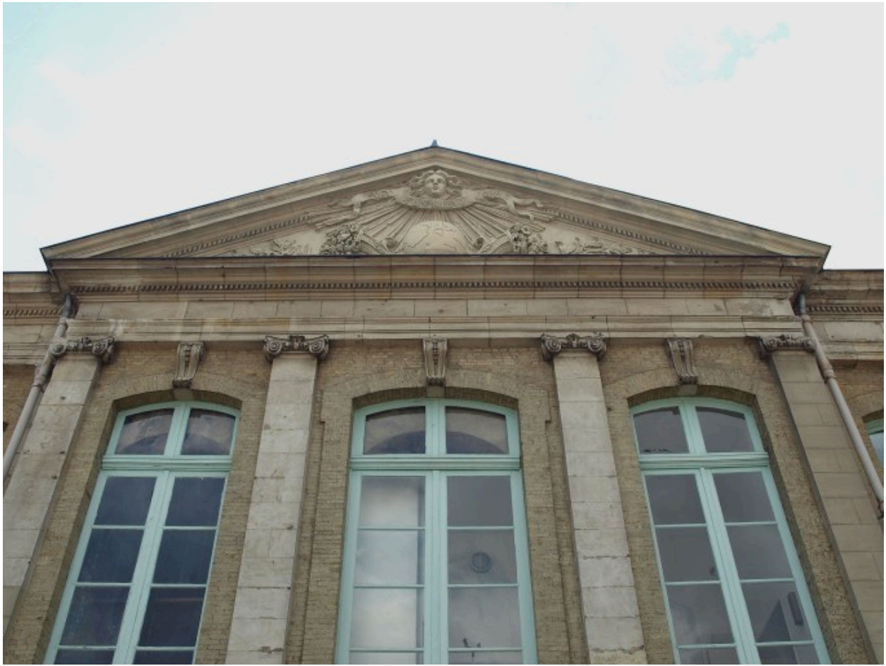
Vue sur la façade du corps de logis principal
