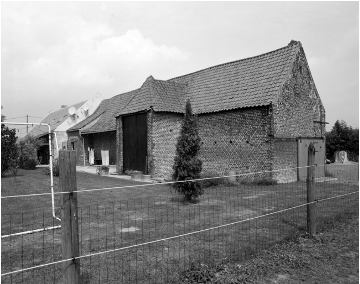
Élévation postérieure de la grange, de trois quarts.
