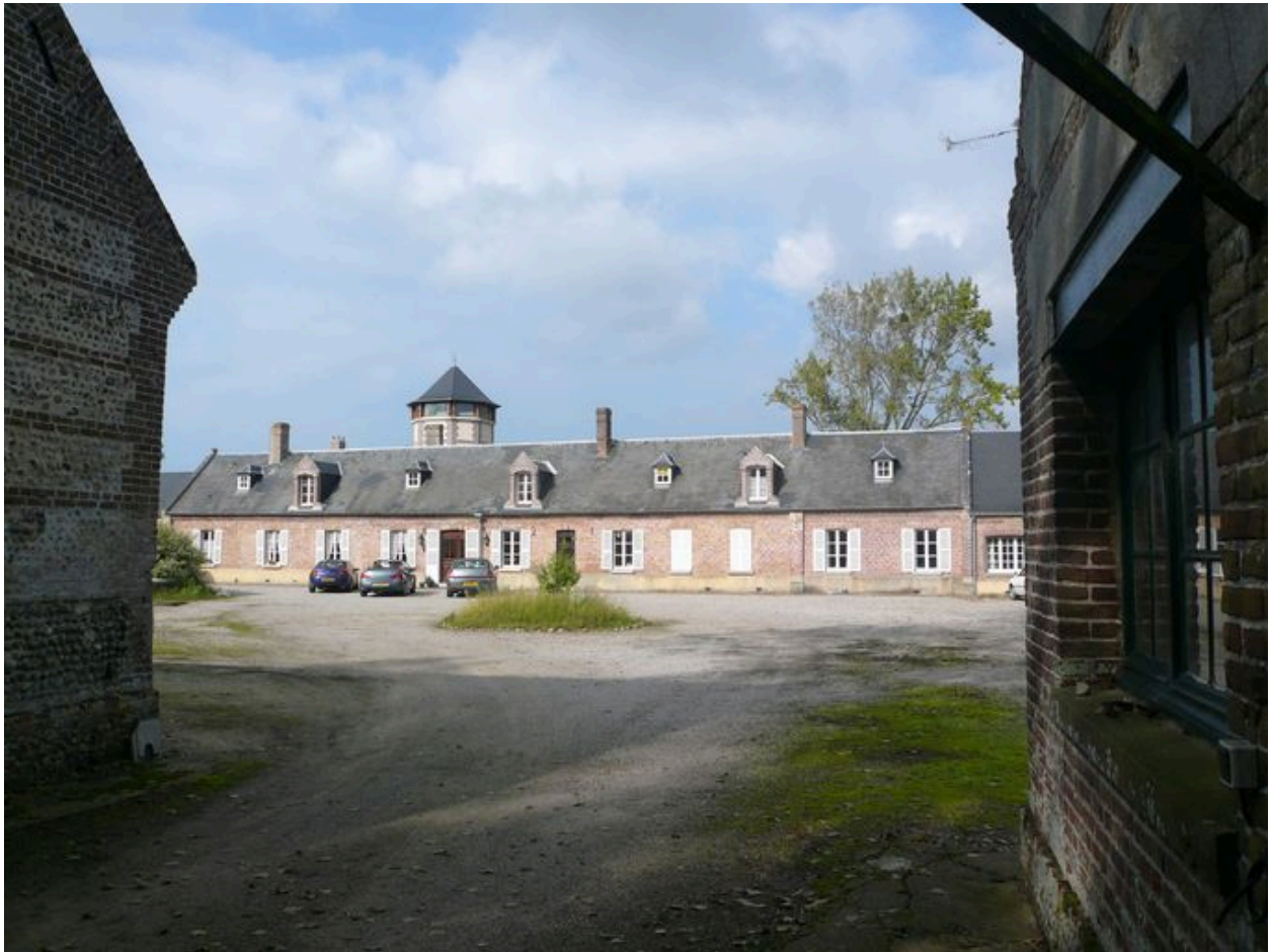
Vue du logis au nord.
