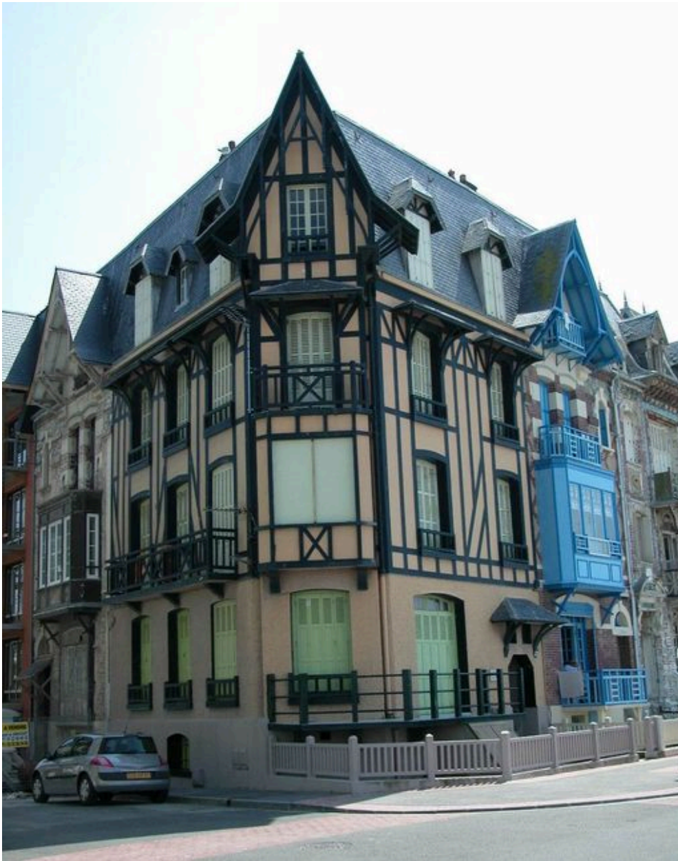
Vue d'ensemble depuis l'esplanade.
