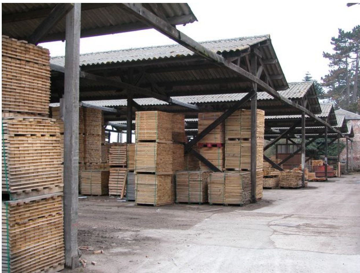
Halles de séchages à l'air libre des bois.
