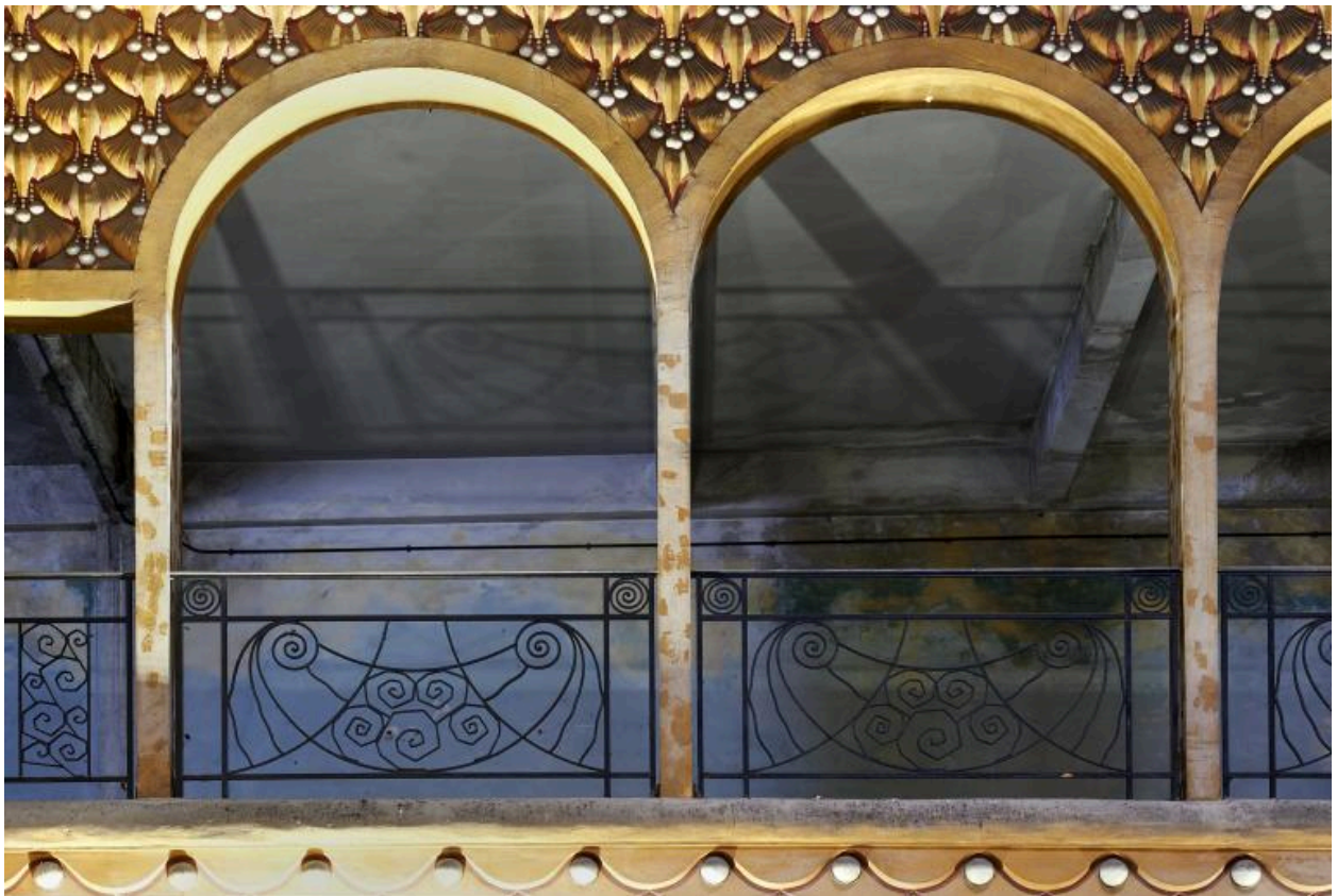
Détail d'une double baie en arcade du grand atrium et son garde-corps en ferronnerie.
