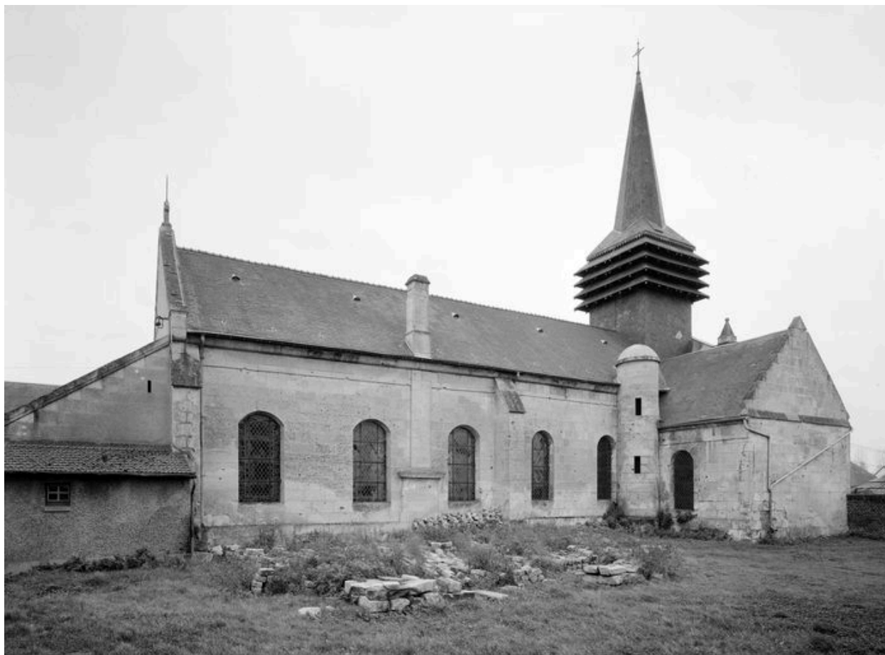
Elévation nord de l'église.
