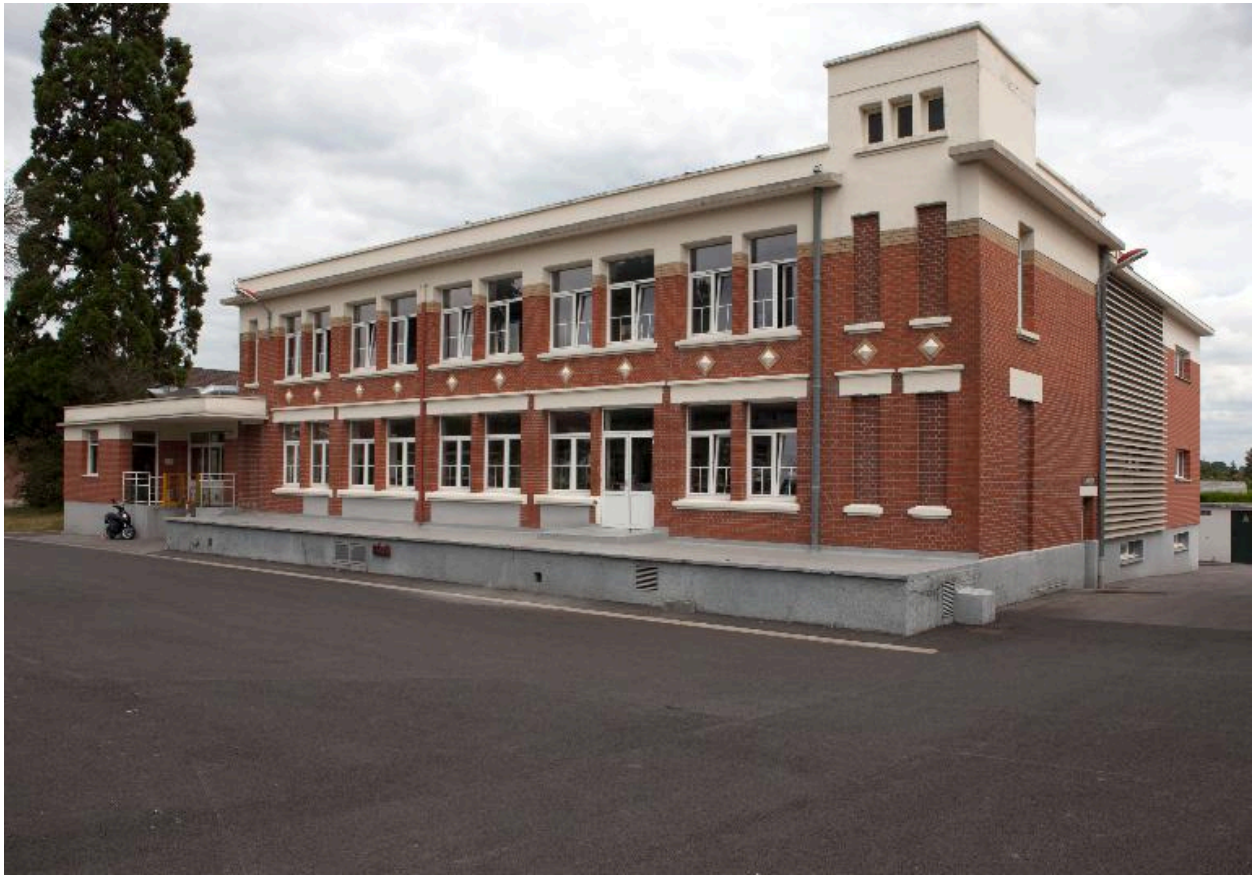
Vue générale de l'ancienne chaufferie, transformée en blanchisserie.
