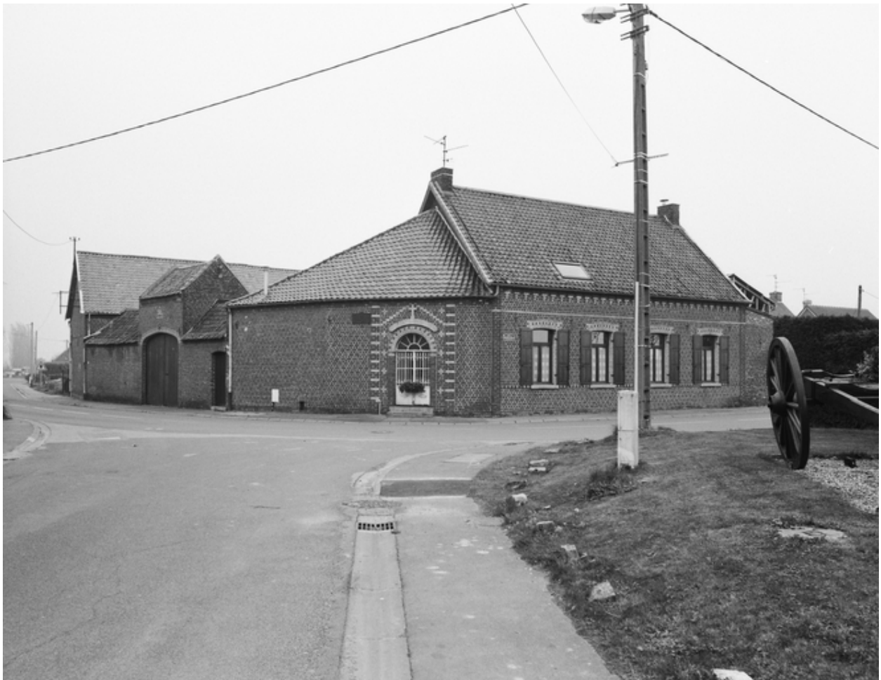
Oratoire ND de la Salette et logis de la ferme, 8, rue Guillocourt, vue depuis la rue.
